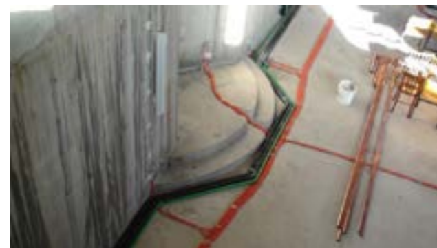
Postavljanje elektro instalacija, grijanja i izrada estriha
