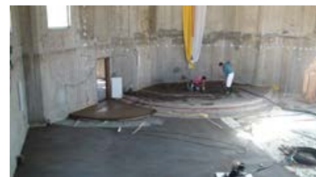
Postavljanje elektro instalacija, grijanja i izrada estriha
