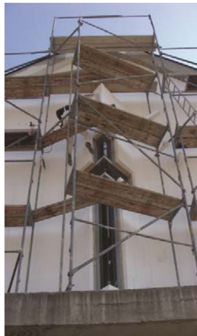
Postavljanje vanjske fasade
